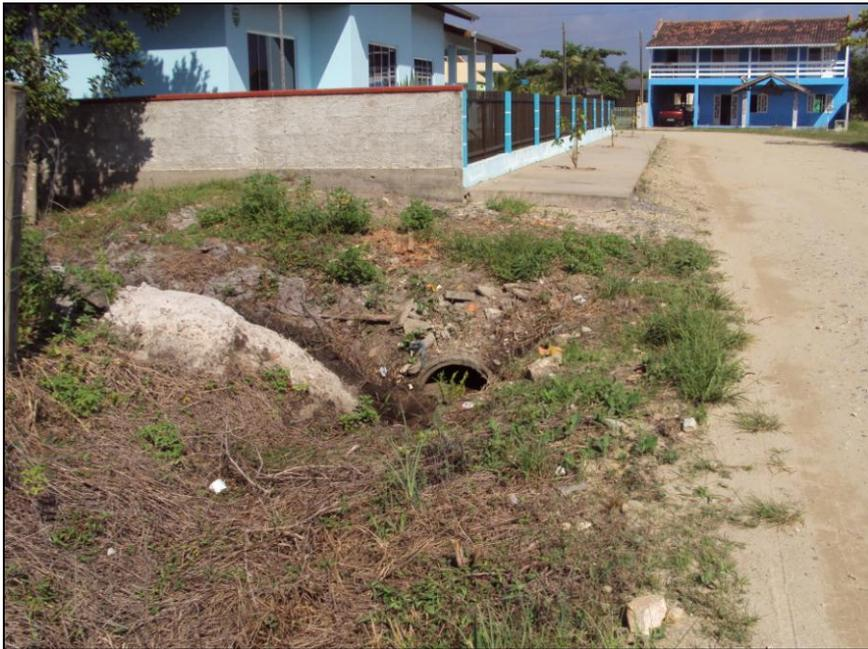
**Figura 40 – Detalhe do bueiro de montante assoreado**
