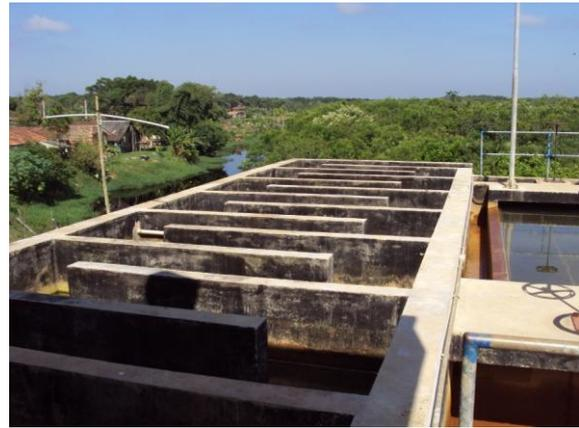
**Figura 11 – Floculador Hidráulico**
