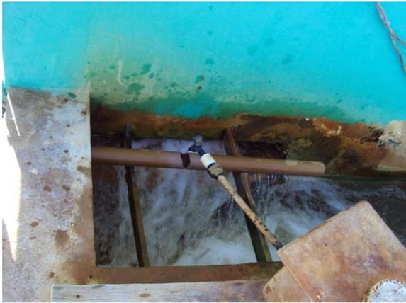
**Figura 10 – Adição de Sulfato de Alumínio**
